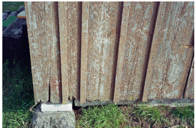
Fassade vor der Sanierung
